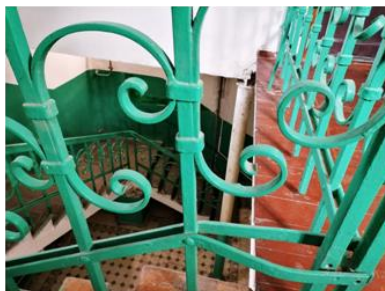
Ограждение лестничных маршей. Фото 2021 г.
