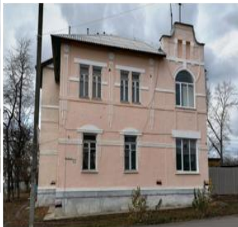
Торцевой фасад здания, выходящий на ул. Комсомольскую
